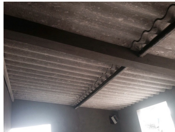
Figura 20 Estructura Metálica y cubierta de Fibrocemento –Fuente Registro fotográfico Propia
