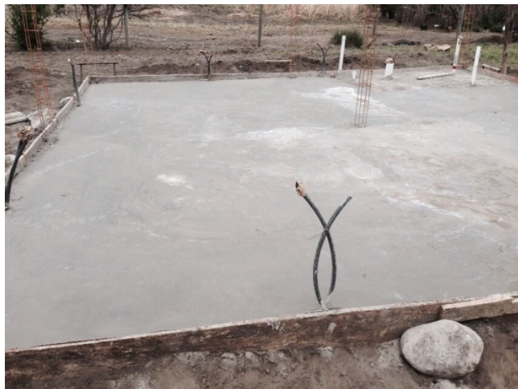
Figura 13. Hormigón en Suelo mejorado y compactado –Fuente Registro fotográfico Propio
