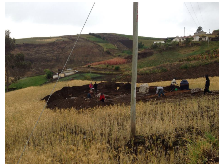
Figura 10 Requerimiento previo limpieza del terreno MIDUVI –Fuente Registro fotográfico Propio
