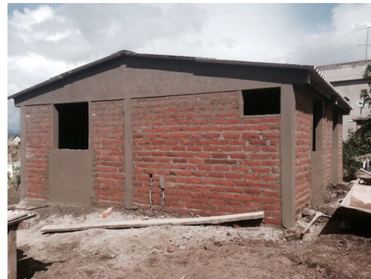
Figura 14. Pilares y fábrica de ladrillo macizo–Fuente Registro fotográfico Propio
